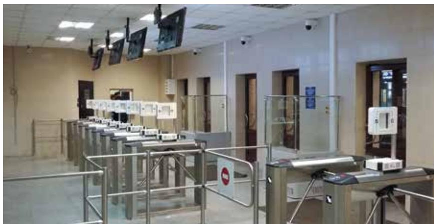
Устройство «Алкорамка» на проходной одного из предприятий
