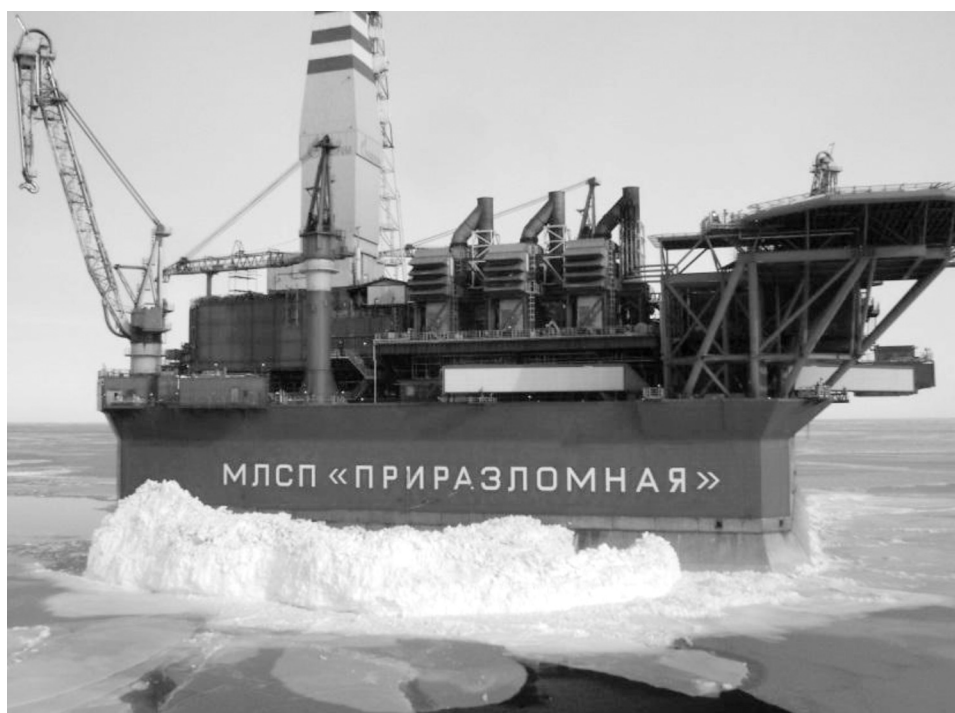
Рис. 8. Нефтедобывающая морская ледостойкая стационарная платформа «Приразломная»
