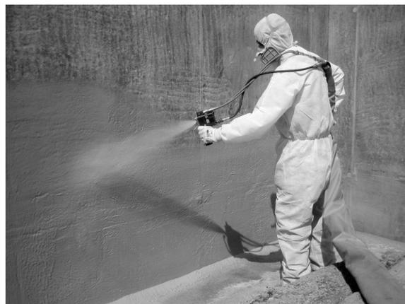
Машина высокого давления для бесшовного нанесения пенополиуретана (ППУ) и полимочевины (ПМ) в работе
