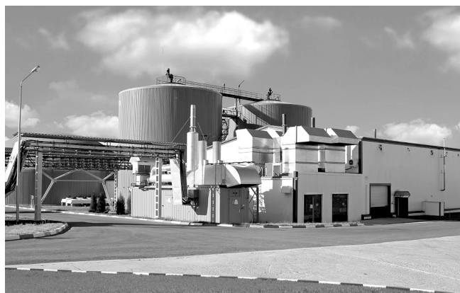
Рис. 6. Биогазовая станция «Лучки» в настоящее время
