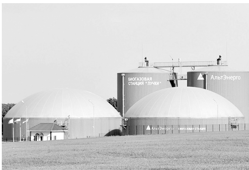
Рис. 2. Биогазовая станция «Лучки»
