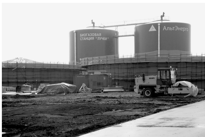
Рис. 5. Строительство станции «Лучки»
