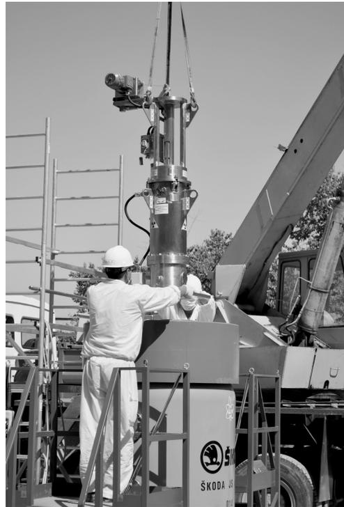
Загрузка пеналов с жидким ОЯТ в контейнер SKODA VPVR/M с помощью перегрузочного контейнера
