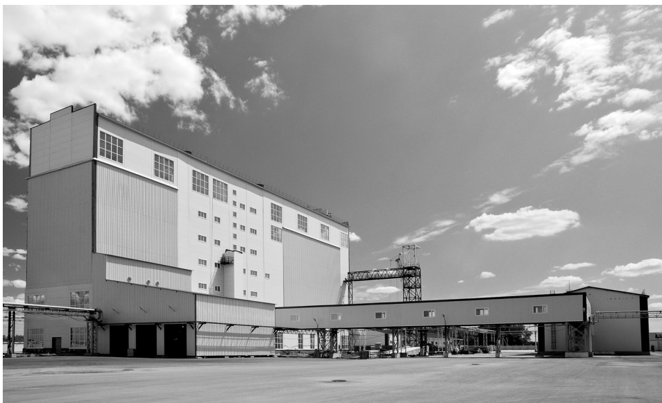
Комбикормовый завод «Пушкинский» (новое предприятие, пуск состоялся 30 июня 2015 г.)
