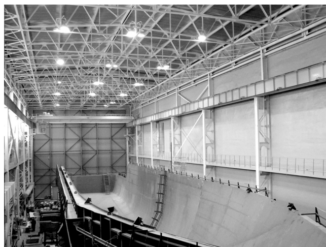
Цех пластикового судостроения после реконструкции
