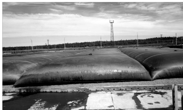
Рис. 4. Общий вид площадки с геоконтейнерами
