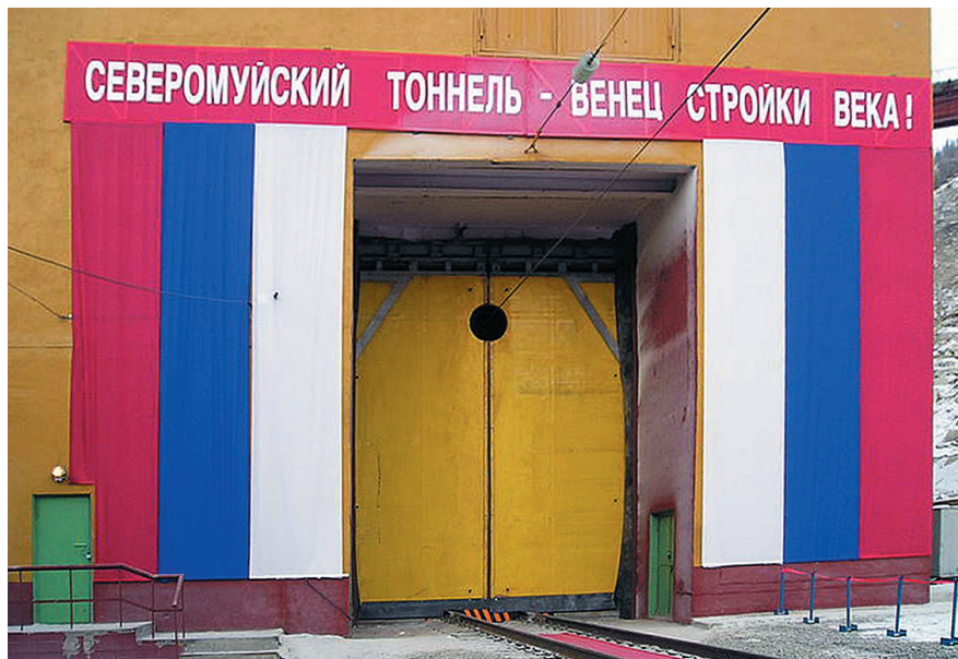
Рисунок 3 Крупногабаритные композитные створки автоматических ворот Северomuysкого тоннеля
