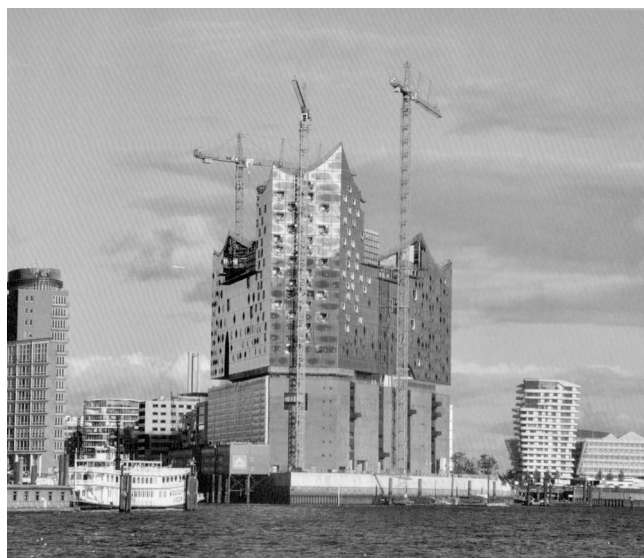
Рис. 4. Сооружение комплекса концертного зала Elbphilharmonie Concert Hall
